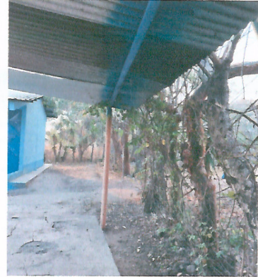
Foto 2: MEJORAMIENTO DE CERRAMIENTO DE MURO PERIMETRAL.
